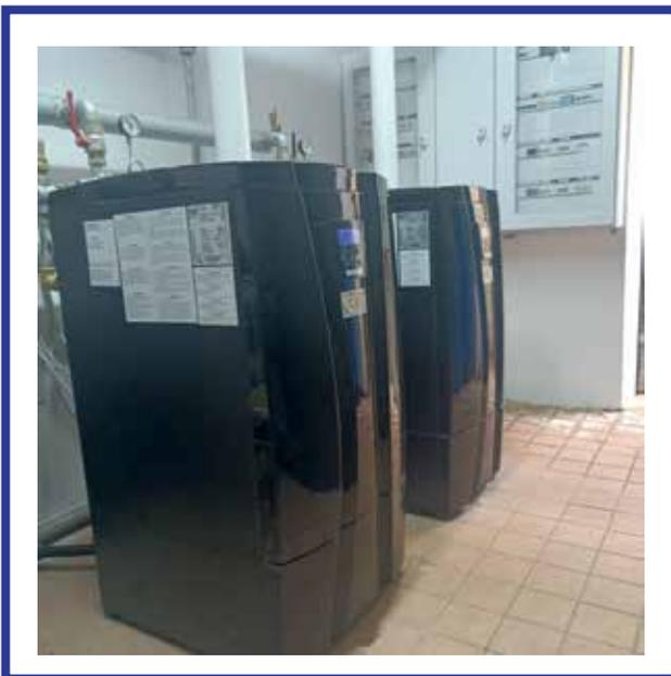
FIGURA 8 - Generatori modulari a gas metano 2 x 115 kWt
