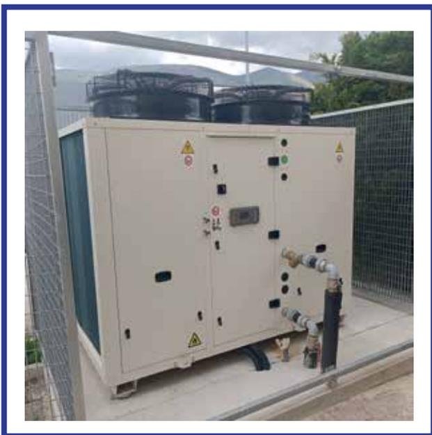
FIGURA 5 - Pompa di calore aria-acqua da 70 kWt nominali
