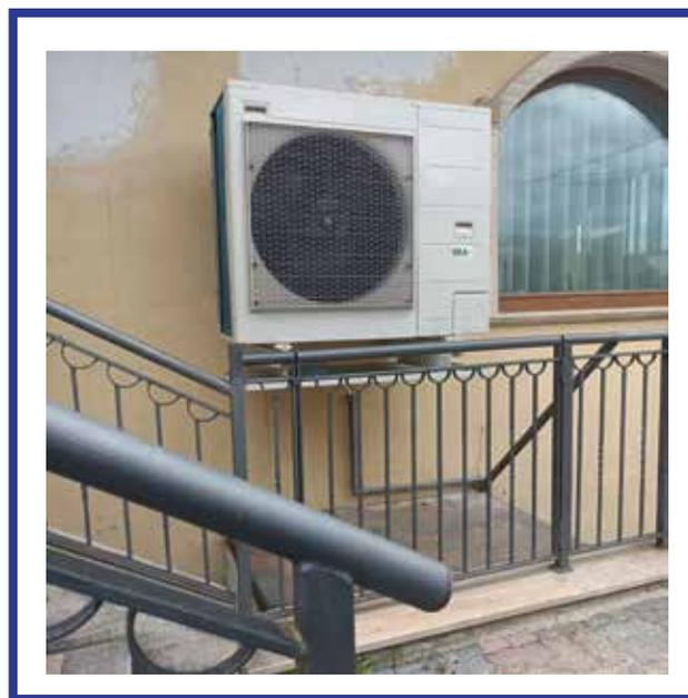
FIGURA 6 - Pompa di calore aria-aria da 25 kWt nominali
