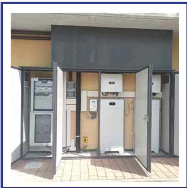
FIGURA 4 - Apparecchiature a corredo impianto fotovoltaico
