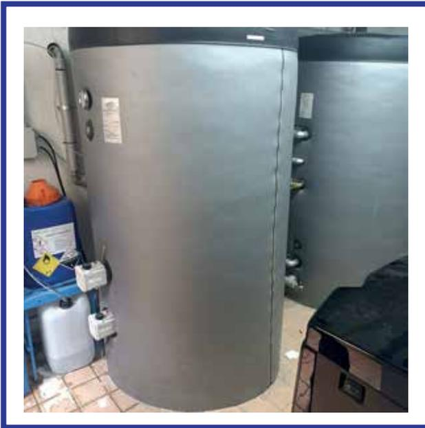
FIGURA 7 - Bollitore da 750 litri con resistenze elettriche 2 x 6 kW
