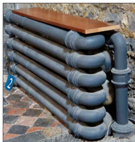
Fig. n. 6B: radiatore costruito sul posto - vista laterale
