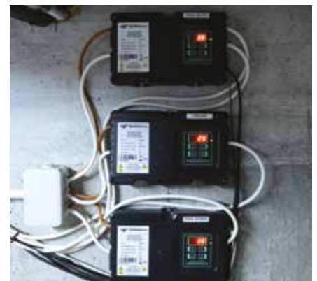
Centraline di regolazione per gruppi di rilancio
