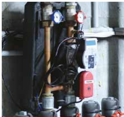
Gruppo di rilancio miscelato modulante per riscaldamento pavimento piscina
