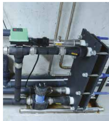
Modulo riscaldamento piscina con scambiatore a piastre e valvola miscelatrice
