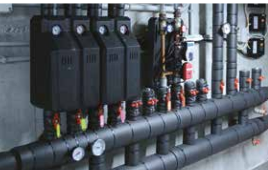
Collettore di distribuzione centrale termica
